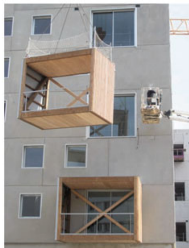
Ces boîtes en bois préfabriquées sont pluggées au moyen d'une grue dans les réserves pratiquées dans les façades béton.
